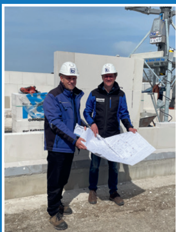
Baustellenbesuche und die Pflege persönlicher Kontakte sind für Borchers wichtig
